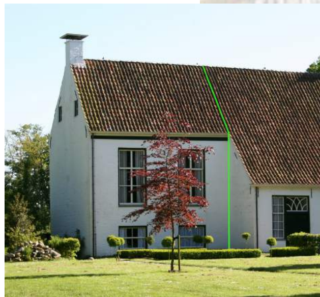
Het steenhuisgedeelte, links van de groene lijn in de foto van het Iwema Steenhuis te Niebert (2005). In vergelijking met het oorspronkelijke steenhuis is het dak tijdens een verbouwing verlaagd en aan de hoogte van de aangebouwde schuur aangepast.
